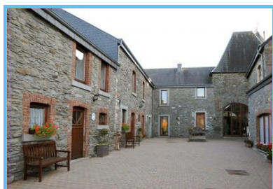
Château-Ferme de Laval
