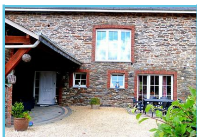
Gîte du Rancourt - Sous la grange
